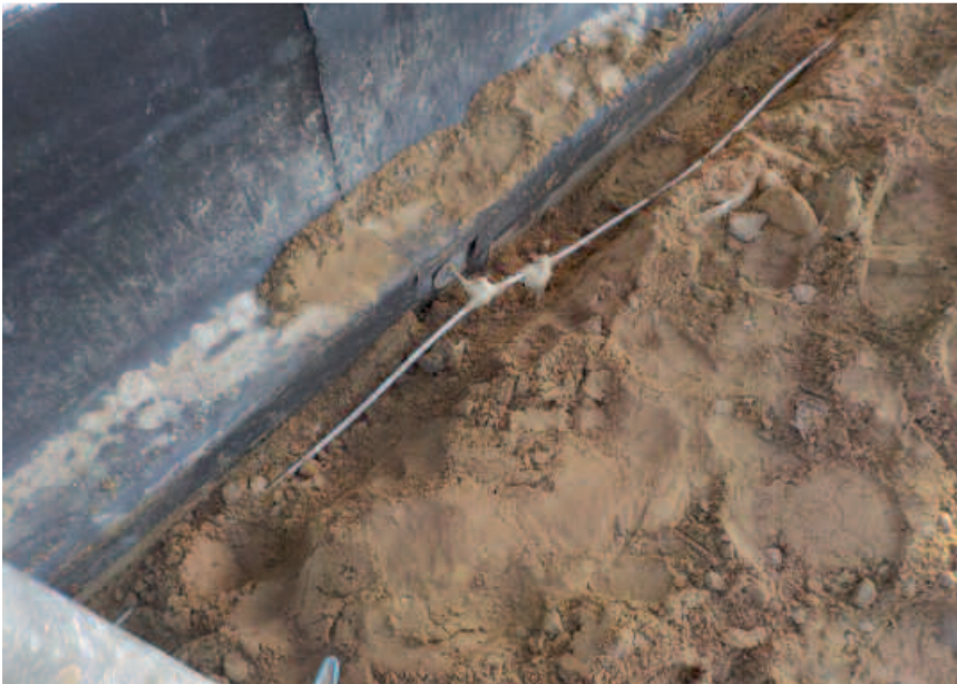
Bild 8: Ringerder aus nichtrostendem Stahl für Blitzschutzanlagen, Werkstoff: 1.4571 (Foto: J. Pröpster GmbH, Neumarkt OPf.)
