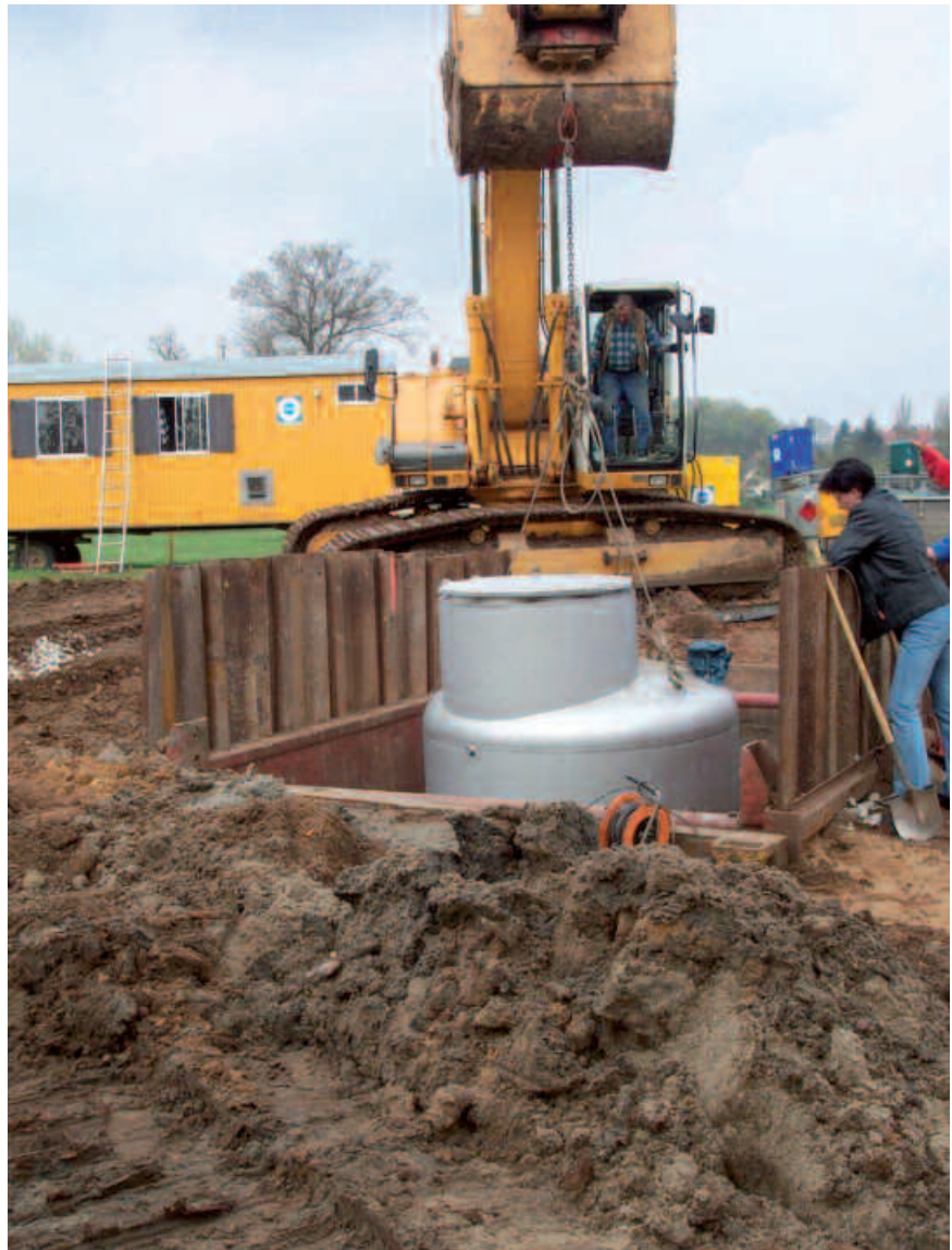
Bild 1: Fertigschacht, der als Brunnenkopf im Erdboden eingesetzt wird, Werkstoff: 1.4307 (Foto: HUBER SE, Berching)
